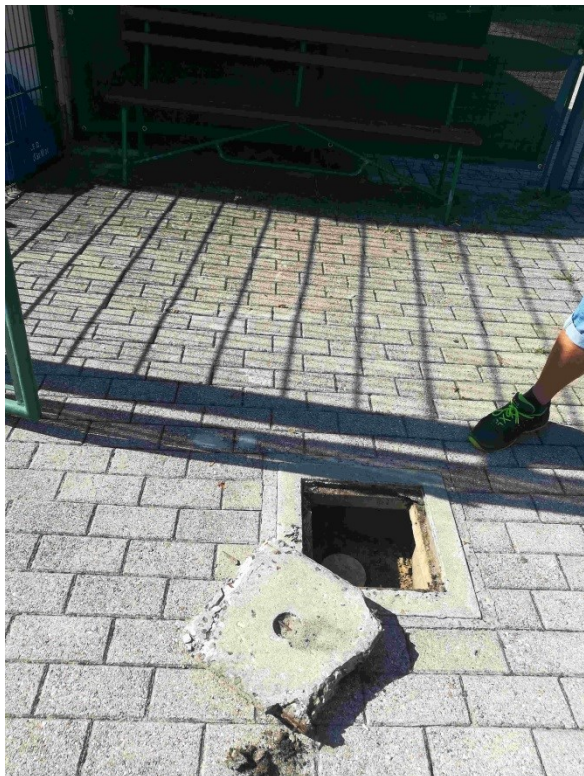
Pozzetto per attacco scarico e pozzetto ove allacciare la tubazione idrica
